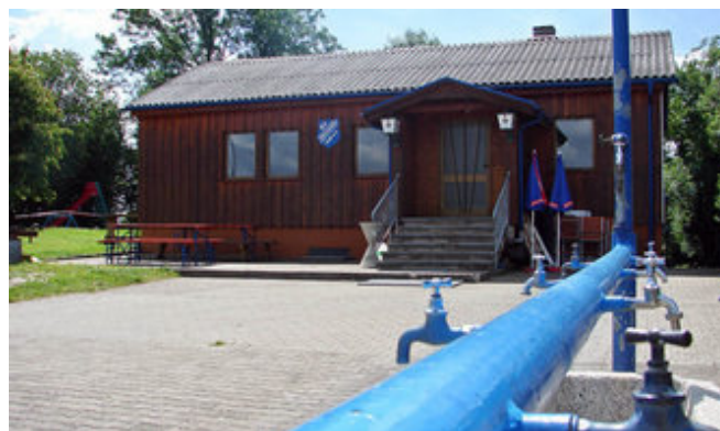
Große Pläne hegt der Sportverein Göschweiler: Neben dem Umbau soll das Clubhaus auch um eine überdachte Tribüne erweitert werden. | Foto: Christa Maier
